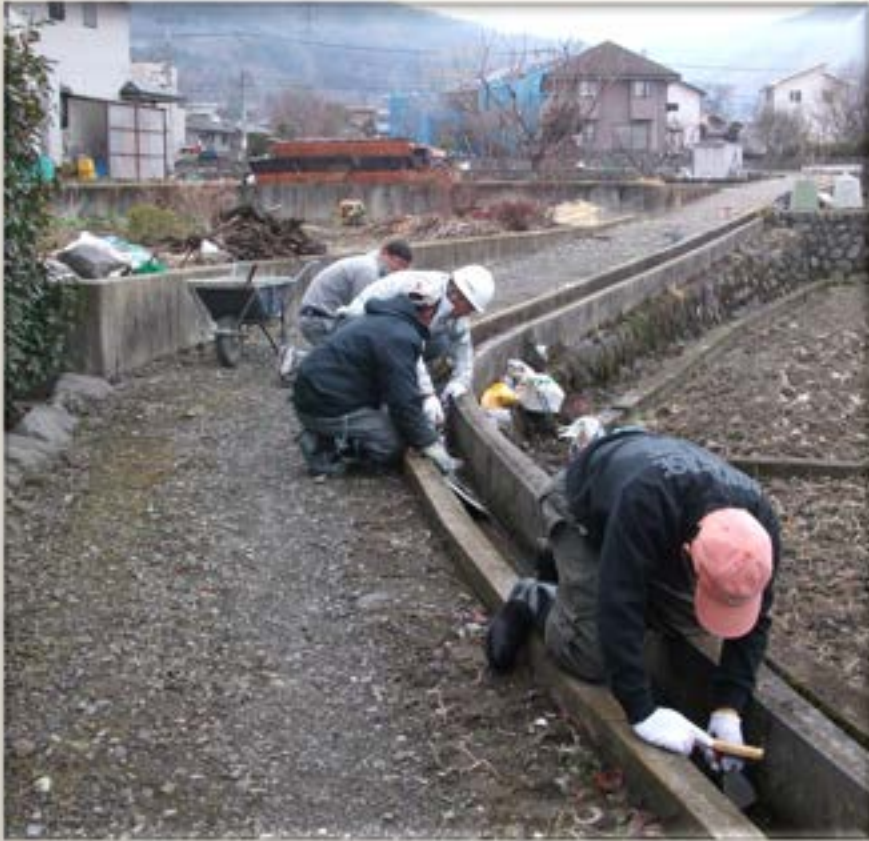
【水路の目地補修】
