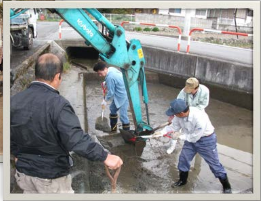
【水路の泥上げ】
