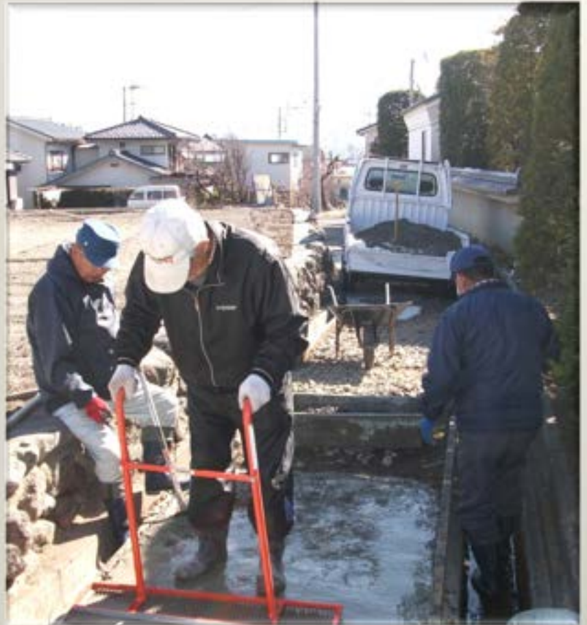
【農道のコンクリート舗装】
