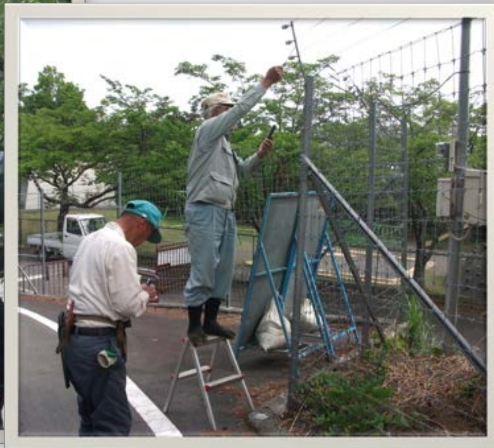
【通電部の電圧チェック】
