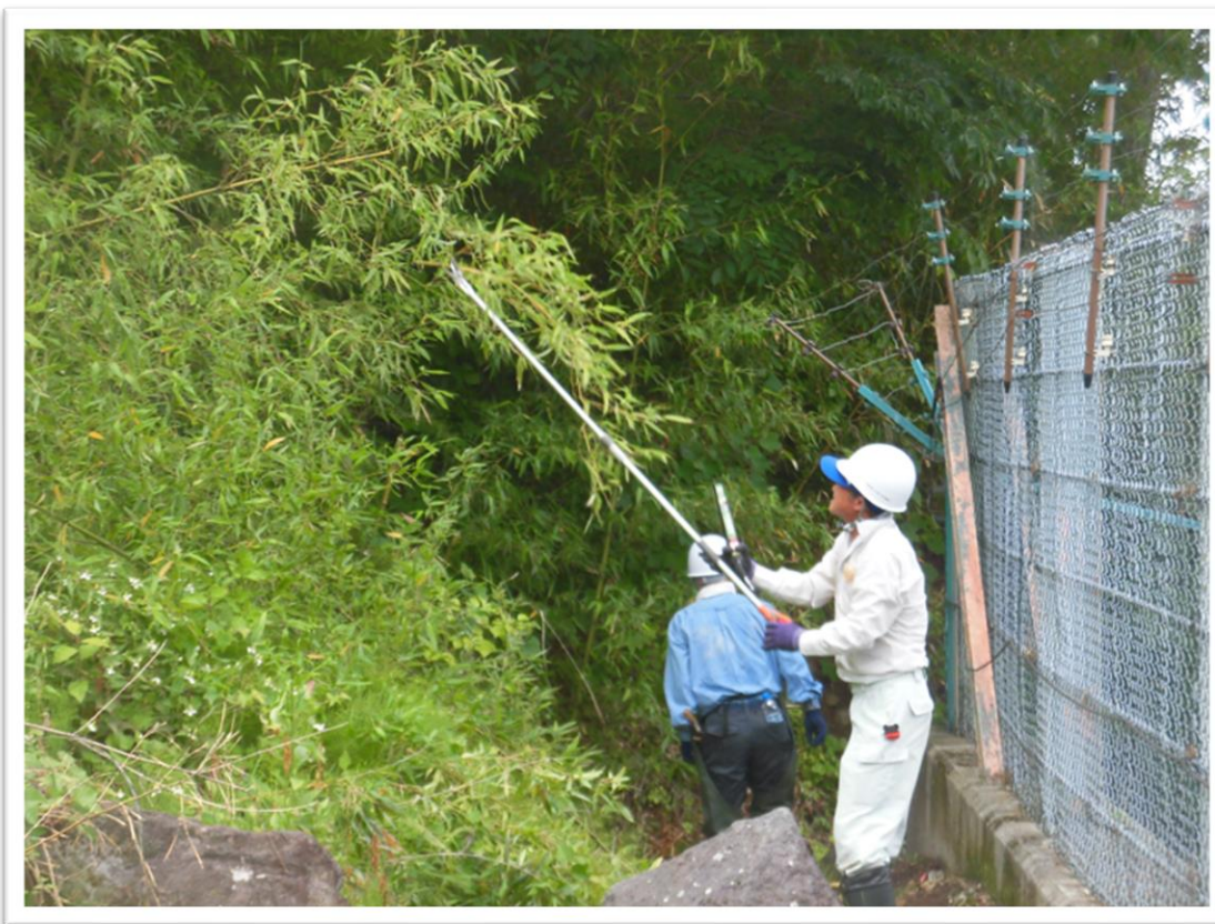
支障木の伐採
